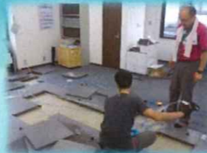
一から配線を直し
