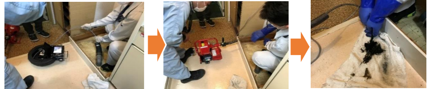
まずはカメラで管内の状況確認
